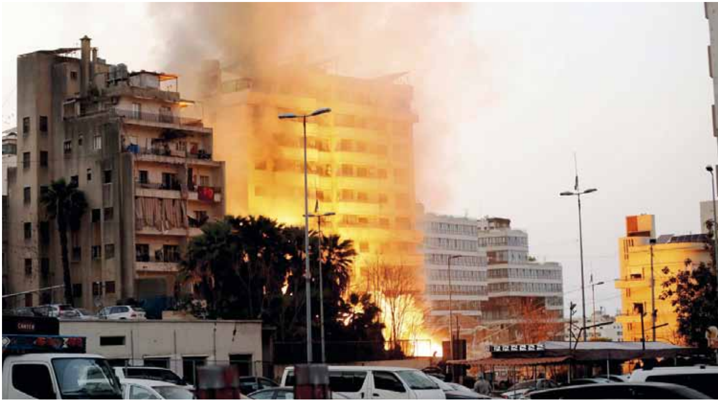
Edificios dañados por un ataque aéreo israelí, en la zona de Bachoura de Beirut.
